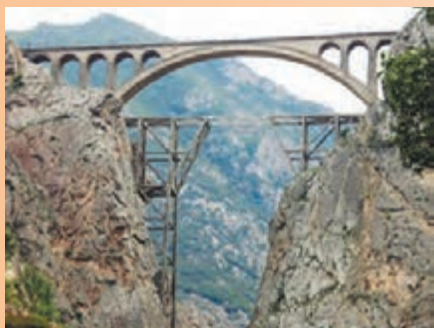
ب) پل ورسک
